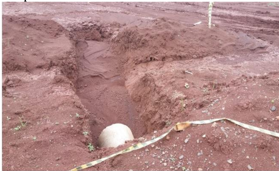
Figura 87: Bocas de lobos entupidas e assoreadas
