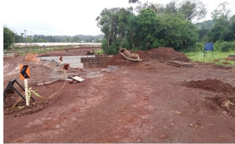
Figura 90: Processo erosivo sendo direcionado ao banhado e leito do Laj. São José
