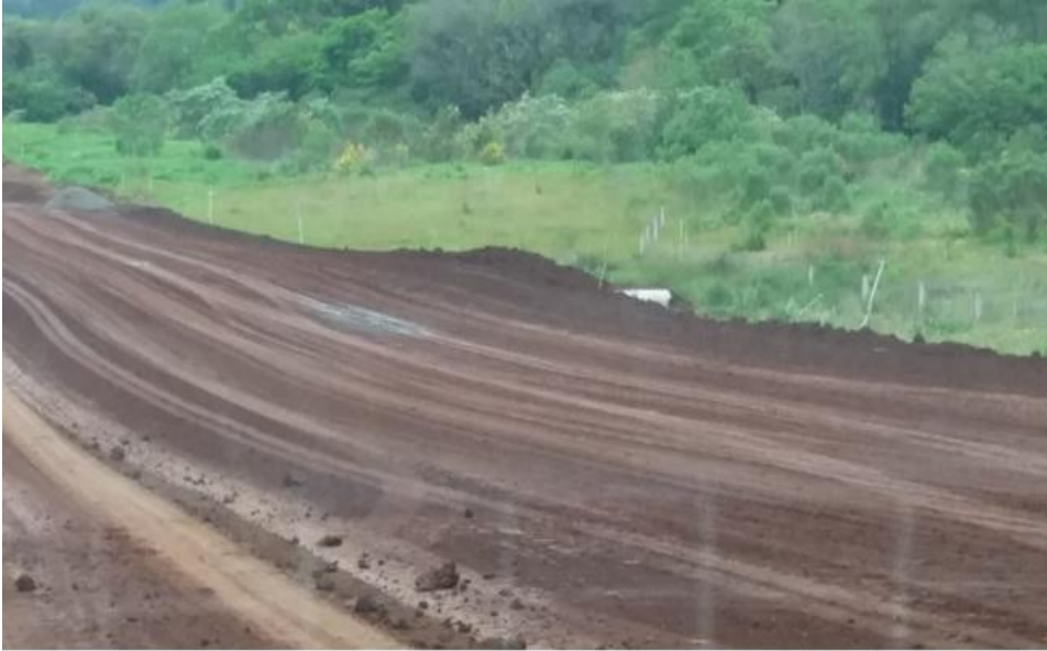
Figura 90: Processo erosivo sendo direcionado ao banhado e leito do Laj. São José
