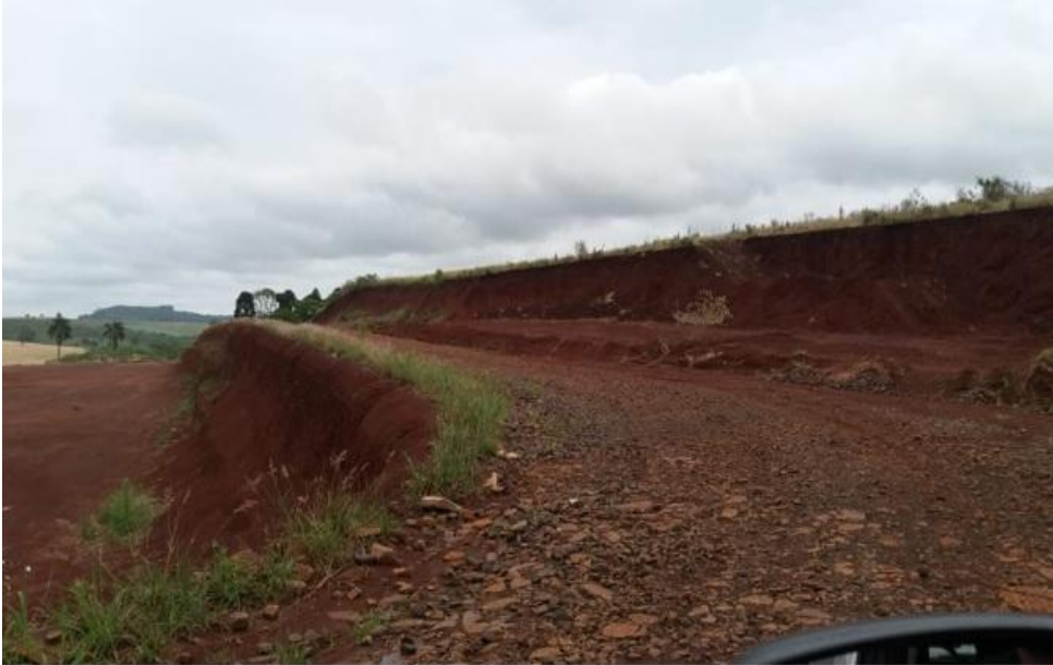
Figura 101: Processos erosivos por falta de cobertura vegetal no terreno
