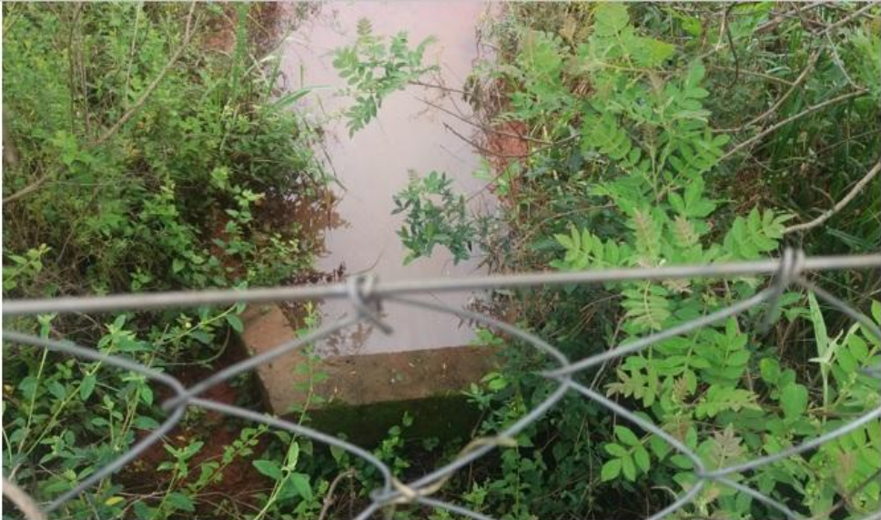
Figura 16: Loteamento Jardins Paraíso, descarga de águas pluviais em nascente e banhado provocando assoreamento
