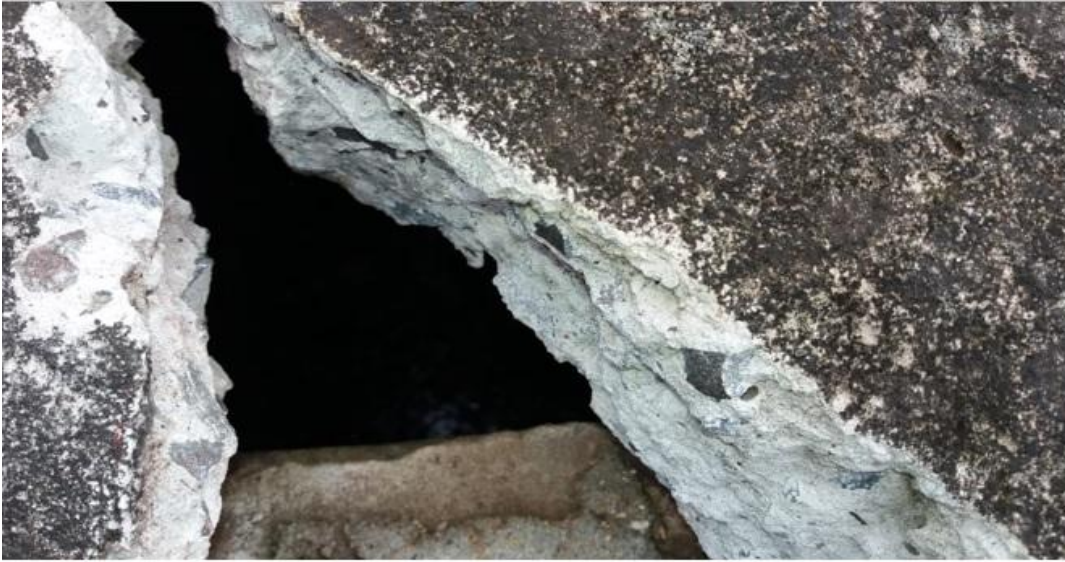
Figura 114: Detalhes da caixa receptora de esgoto
