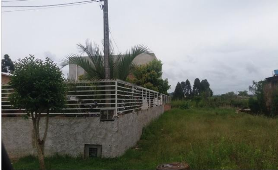
Figura 57: Entulhos e aterramento de banhados
