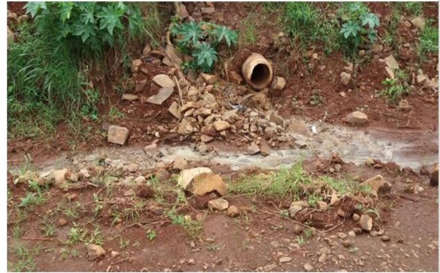
Figura 101: Processos erosivos por falta de cobertura vegetal no terreno
